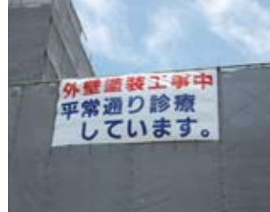
工事中もしっかり 診療しています!
